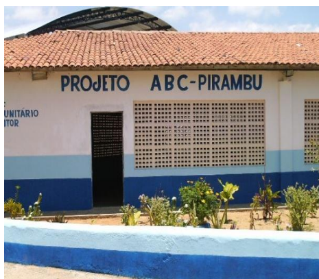
Foto1 – Fachada Projeto ABC
