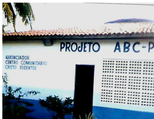
Foto 2 – Fachada Projeto ABC
