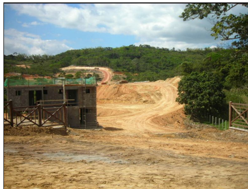
FIGURA 29: Construção de Condomínios em Guaramiranga-CE
