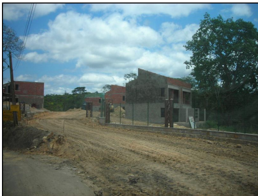
FIGURA 28: Construção de Condomínios em Guaramiranga-CE
