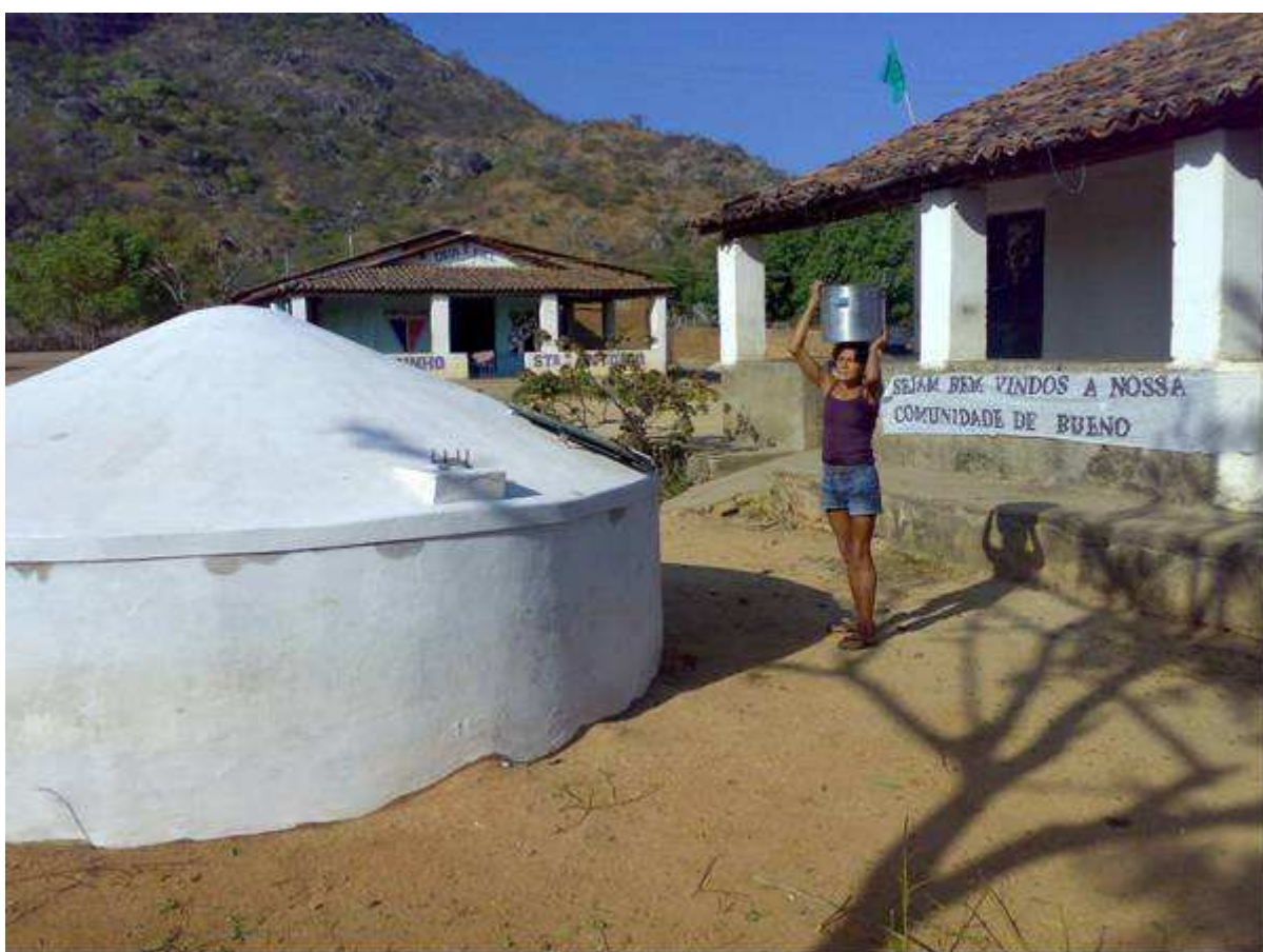
Fotografia 4 – Cisterna de placa construída no Sítio Bueno.
