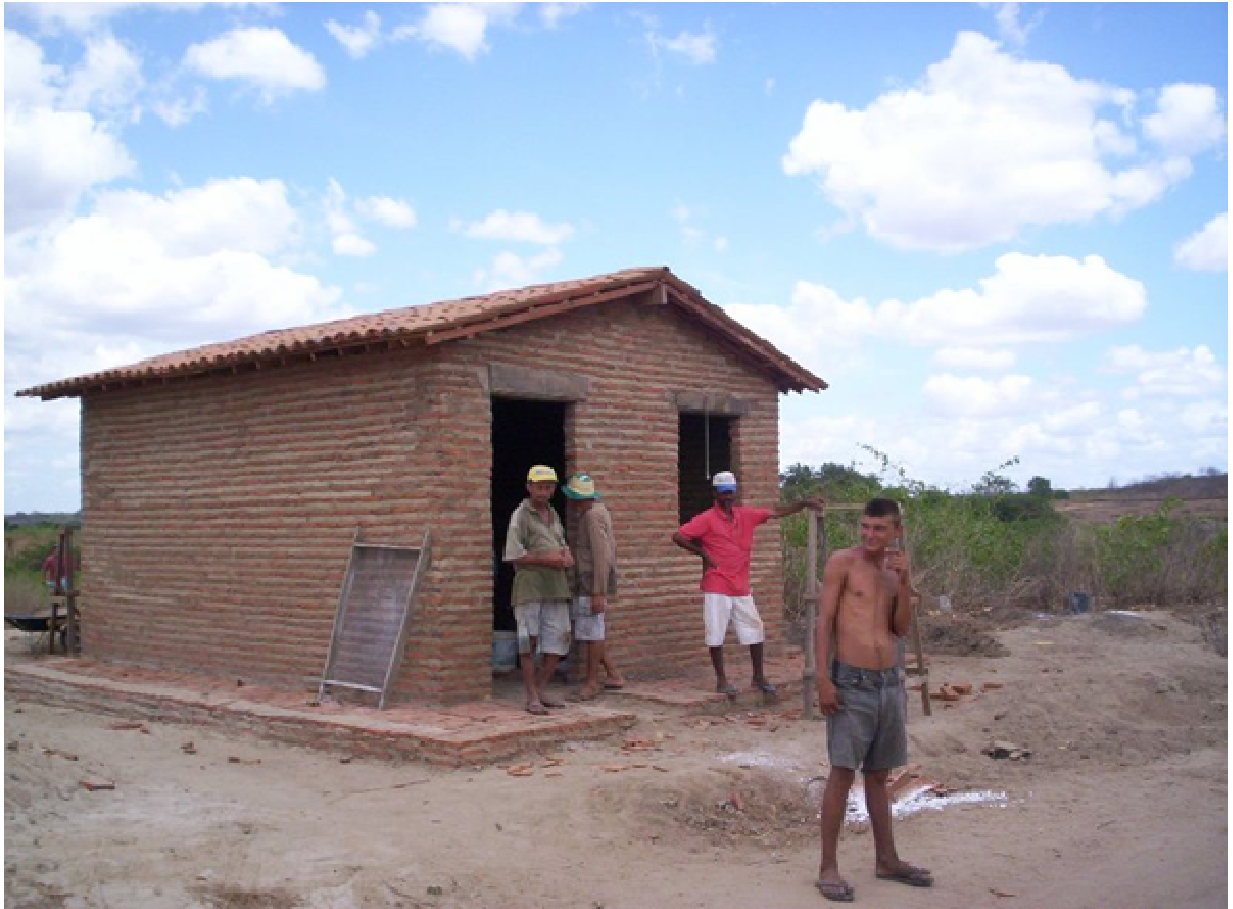
Fotografia 1 – Foto da Casa de Semente Comunitária Caiçara (Missi), sendo construída em mutirão.
