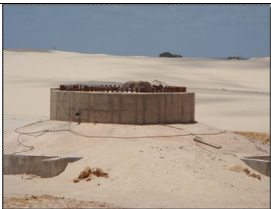
Figura 37- Construção da base
