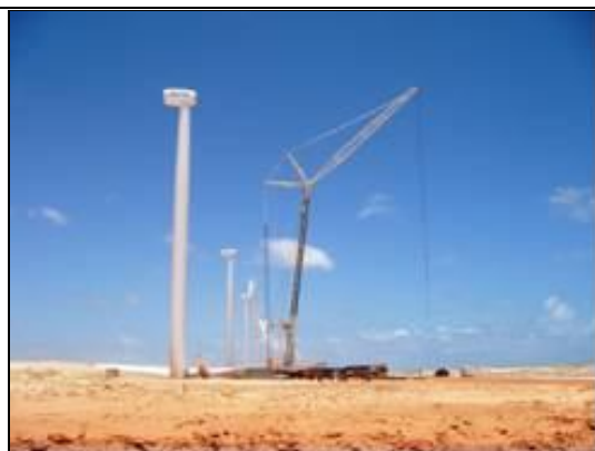
Figura 38 - Montagem das torres
