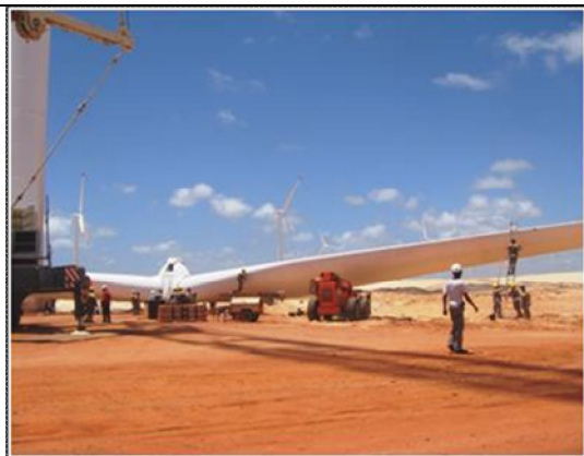
Figura 40 - Montagem das pás
