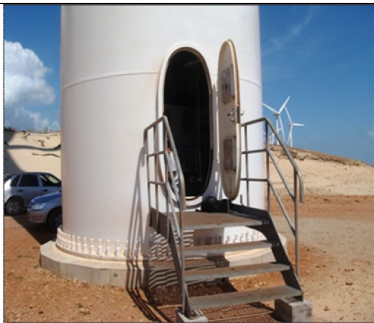
Figura 44 - Manutenção do Aerogerador
