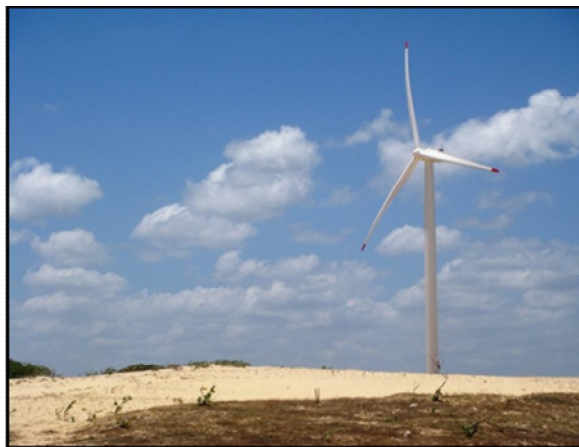
Figura 29 - Aerogerador de eixo horizontal
