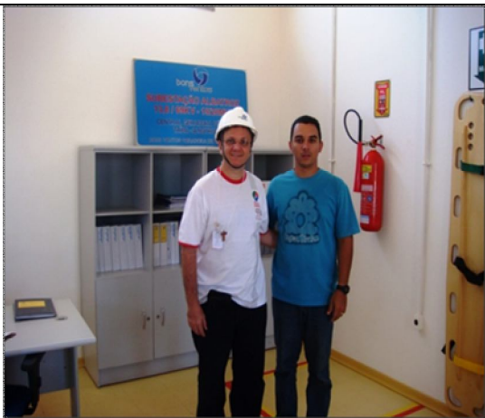
Figura 43 – Sala de Controle Operação do Parque
