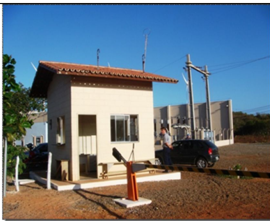
Figura 46 - Guarita de entrada do parque
