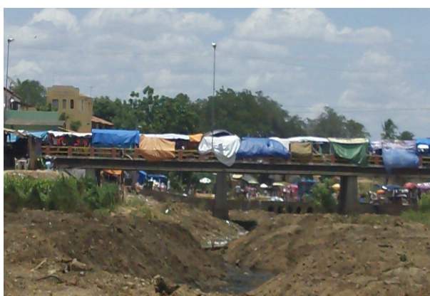
Foto-4: Barracas sobre a Ponte do Rio Canindé
